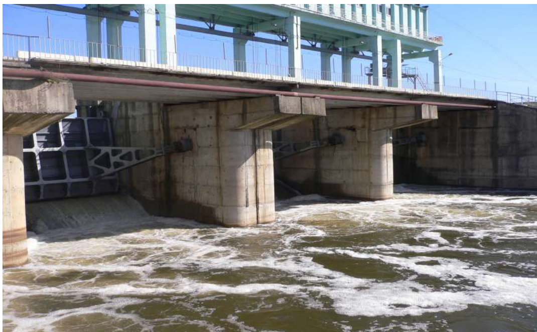
Рис. 15.19. Гидроузел Курского водохранилища
